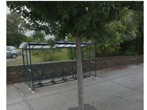
Stationnement protégé – Avenue Mendès France
