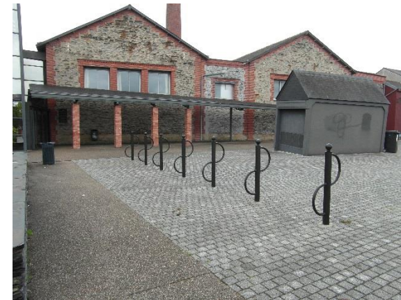
Poteaux acier – Médiathèque
