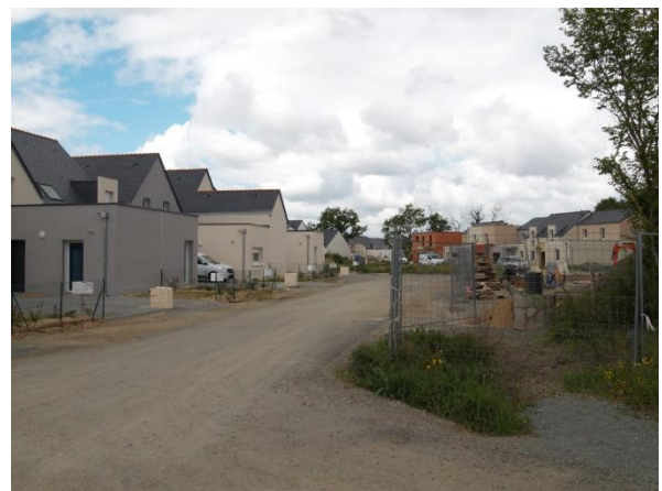
Photo 18 : Exemple de travaux : à proximité de la rue André Malraux. Photo : Corentin Vigne
